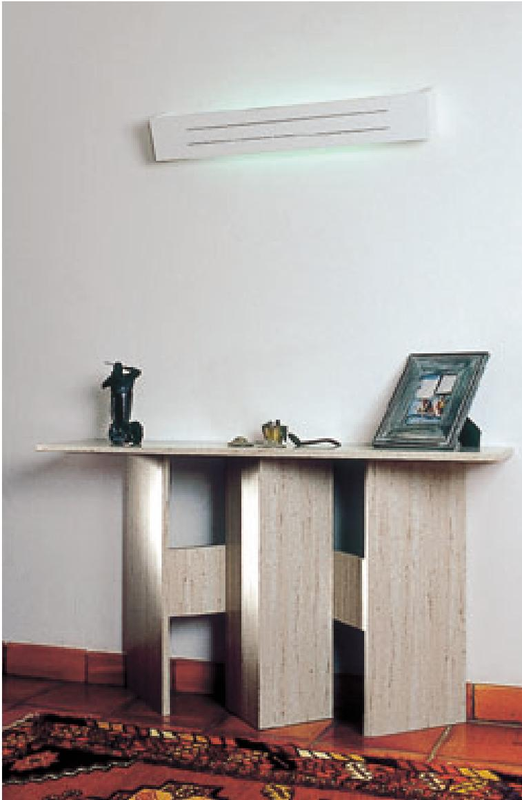
La façade du bandeau est constituée d'un rectangle en panneau d'aggloméré de 13 cm de hauteur et 84 cm de longueur pour un tube fluorescent de 60 cm (18 watts). Les deux joues sont des trapèzes rectangulaires de 13 cm d'un côté et 8,5 cm de l'autre.
